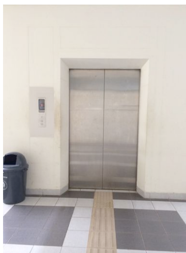
Gambar 14. Jalur penggunaan difabel buta terputus di depan lift tanpa disertai informasi Braille
