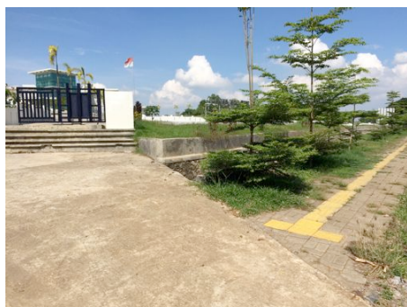
Gambar 12. Jalur sirkulasi pengguna difabel buta dari luar tapak ke jembatan layang terputus
