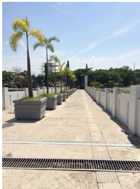
Gambar 5. Jembatan layang menghubungkan Jalan Poros Malino dengan Lantai 1 unit-unit bangunan di dalam kampus yang panas, sepi dari pengguna pejalan kaki
